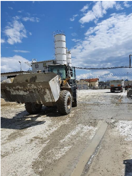
Odvoženje vode od pranja miješalice utovarivačem do reciklatora
