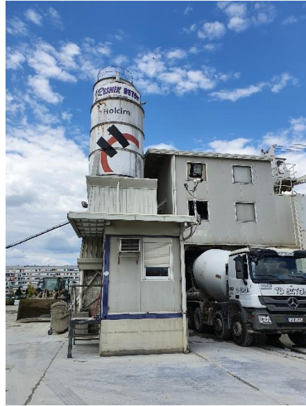
Ispuštanje pripremljenog svježeg betona u automješalicu (mikser)
