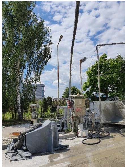
Pročišćavanje vode od pranja miješalice u reciklatoru
